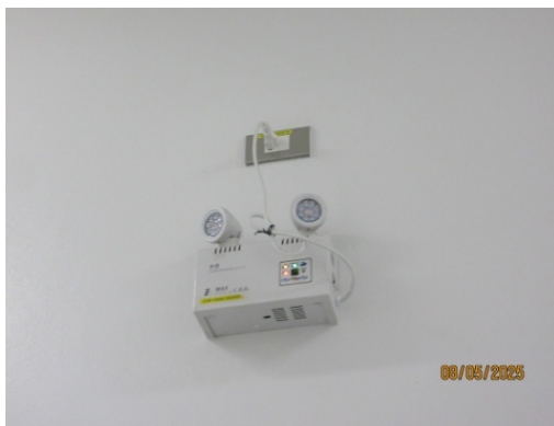
รูปที่ 35 Emergency Light System
