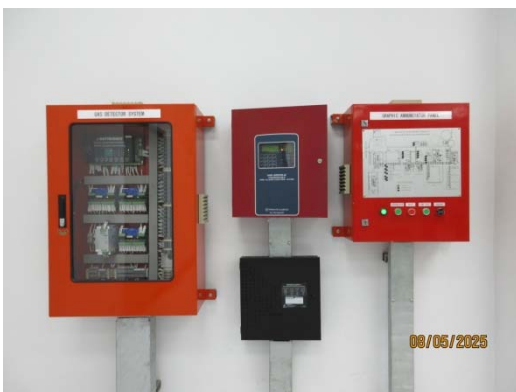
รูปที่ 29 Gas Detector System
