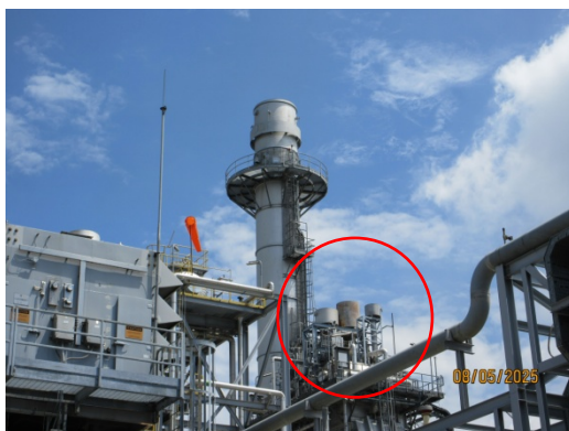
รูปที่ 7 Silencer บริเวณควาล์วท่อระบายน้ำ
