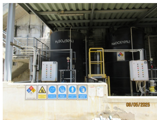
รูปที่ 55 กังแพงคอนกรีตล้อมรอบถังน้ำมันและสารเคมี
