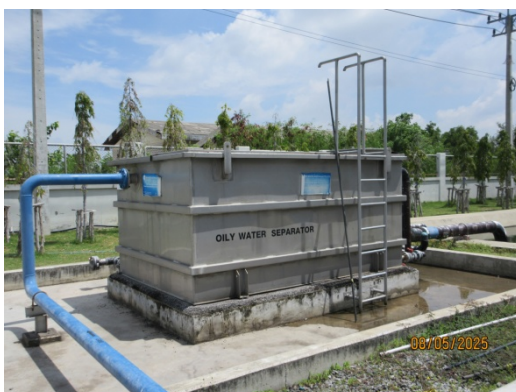
รูปที่ 13 ถังแยกน้ำ-น้ำมัน (Oil Separator)
