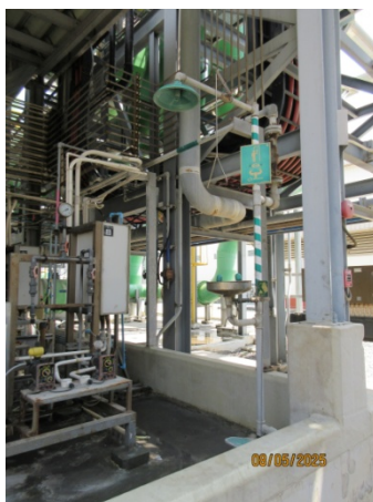
รูปที่ 54 อ่างล้างตาฉุกเฉิน และฝักบัวชำระล้างร่างกาย
