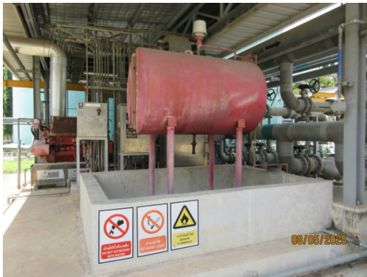
รูปที่ 51 ถังเก็บน้ำมันดีเซล สำหรับจ่ายให้กับ Fire Pump
