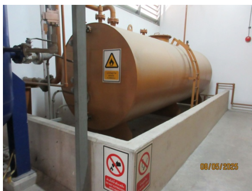
รูปที่ 55 กังแพงคอนกรีตล้อมรอบถังน้ำมันและสารเคมี
